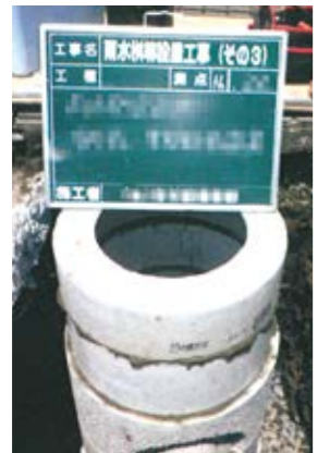
▲浸水対策として設置された雨水枥
